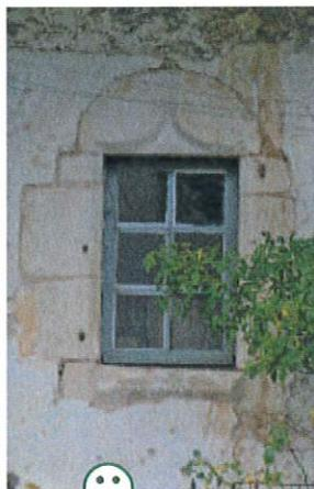
Les encadrements des ouvertures et les chaînages d'angle en pierre de taille ou en briques sont conçus pour être vus. Ils ne doivent pas être peints.
