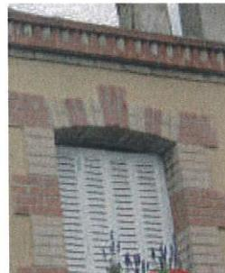
La brique est utilisée ponctuellement dans le pays Montmorillonnais et a une fonction décorative sur les façades ou les clôtures ou une fonction structurelle en remplaçant la pierre de taille dans les encadrements et chaînages d'angle. En revanche, elle est largement employée dans la création des cheminées.
