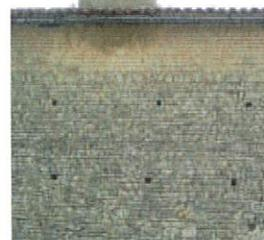
La disposition régulière des moellons et des pierres de taille, la qualité de la pierre et de sa taille, rendaient les maçonneries plus résistantes aux facteurs climatiques et, de ce fait, celles-ci pouvaient rester nues.
