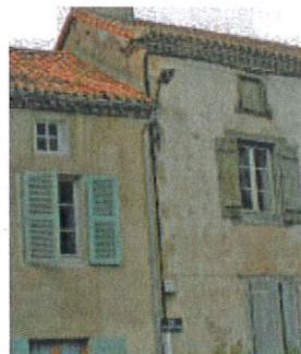
Dans le comble « à surcroît » le sol est au-dessous du sommet des murs gouttereaux. Le volume exploitable est ainsi augmenté. Il n'y a pas de lucarnes sur ce toit. On reconnaît le surcroît par la présence de petites ouvertures. Ce type de comble est très répandu sur la maison de type poitevin.
